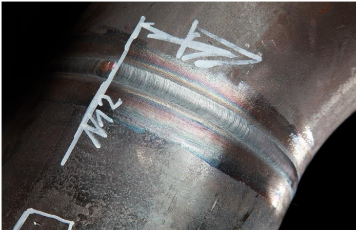
Zerstörungsfreie Prüfung der Rundnaht
