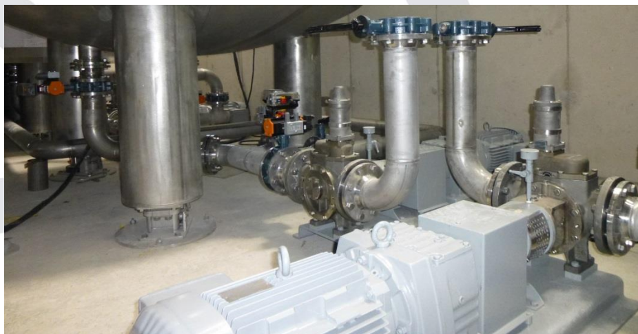
Farbversorgung einer Streichmaschine für die Papierindustrie
