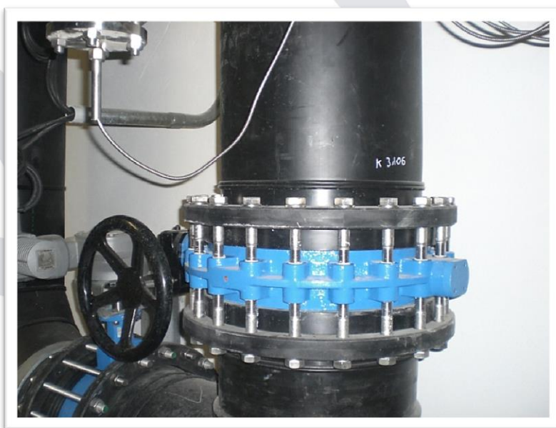
Rohrleitung DN600 PN10 für eine Abwasserreinigungsanlage Werkstoff PE100 SDR11
