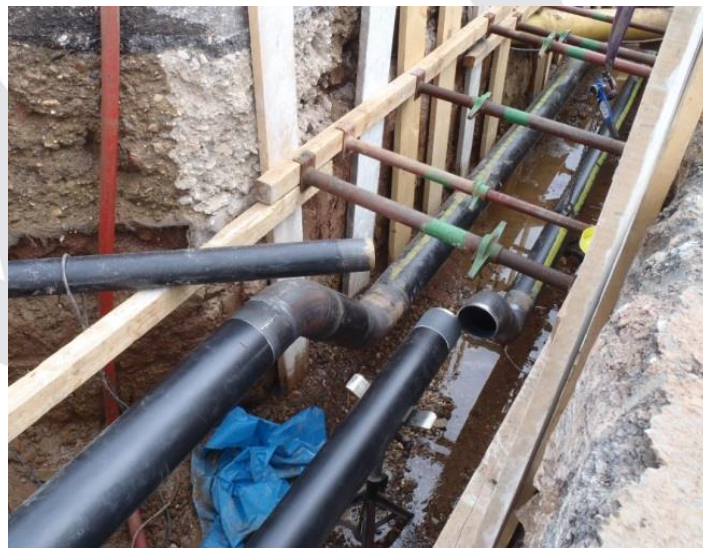
Erdverlegte Gasrohrleitungen DN200/PN16
